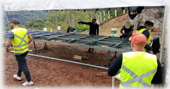
Obra Chalé em Chapecó SC
